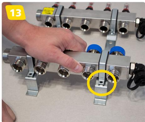
Drücken Sie den Rücklauf vorsichtig herunter sodass Klammer und Stange mit einer Schraube in der dafür vorgesehenen Lochung befestigt werden können.
