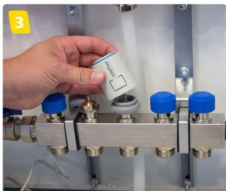
Platzieren Sie den Stellantrieb auf dem Ventil und drehen Sie diesen fest.
