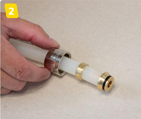
Nehmen Sie einen Adapter Klemmverbinder und bringen diesen wie im Foto zu sehen, am Ende des Heizrohres, an.
