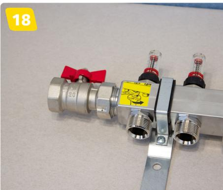
Der rote Kugelhahn ist am Vorlauf zu befestigen. Beide Kugelhähne sind wasserdicht anzuziehen.
